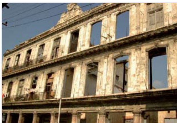
Die Fassade und das gesamte restliche Gebäude sind inzwischen weggerissen.
